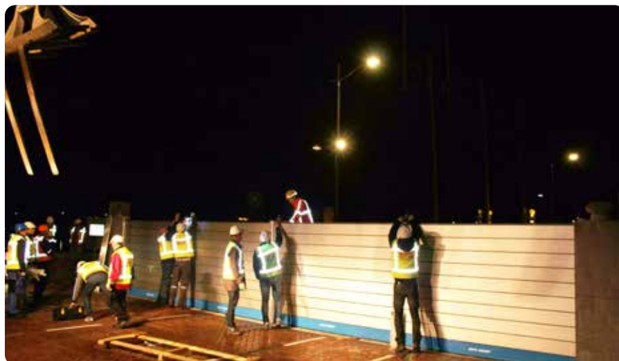
Proefsluiting schotbalkenkering Kampen
